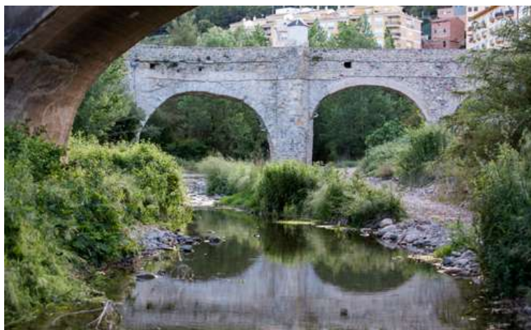
Imagen del puente de San José con el río Montán pasando por debajo de uno de sus arcos.
